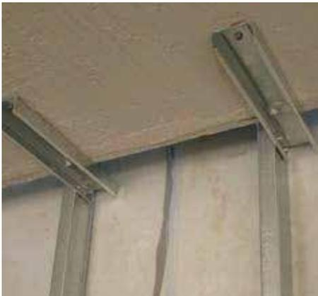
El armado de los bastidores debe realizarse con canales estructurales cal. 22 sujeto con anclajes @40.6 y postes estructurales cal. 20 colocados máximo @40.6cm.
