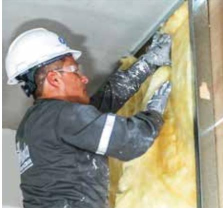
Utiliza el aislante de fibra de vidrio para agregarle mayor valor térmicoacústico a tu muro, colocándola con un pegamento o con tornillos.
