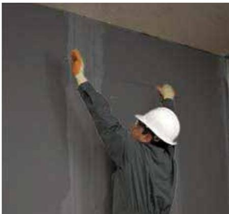
Coloca la Plaka Bunker de tal manera que la cara rugosa quede al exterior y la cara lisa al interior de los bastidores. Fija los tornillos cemento-metal 20 de 1 1/4 " máximo @20cm de separación.
