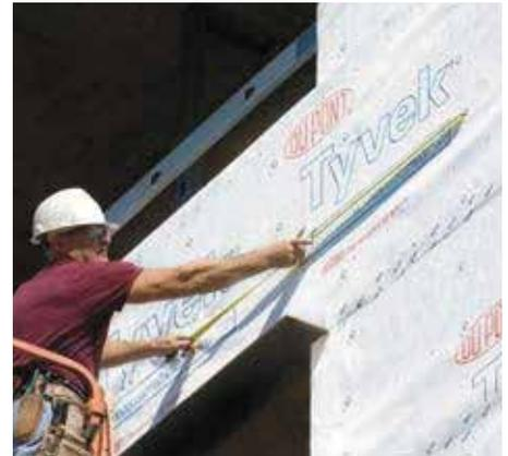
No olvides colocar tu membrana impermeable DuPont® Tyvek® para proteger tus bastidores ya que permite que la humedad del interior salga pero no que la humedad del exterior penetre.
