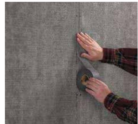
Aplica una capa de Base Coat BunkerMax y Cinta Fibatape AR en todas las uniones, después aplica de una a dos capas de Base Coat Bunker a toda la superficie de tu fachada para dar el acabado final.
