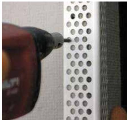
Recuerda usar esquineros plásticos y fijarlos con tornillos cemento-metal 20 de 1 1/4" y aplicar Base Coat BunkerMax para cubrirlo, así protegerás y perfilarás las esquinas.
